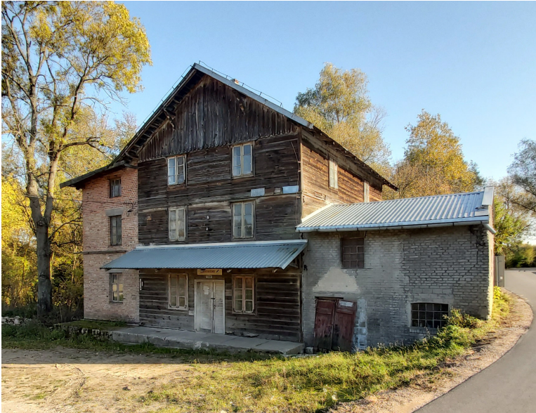
Adamowo – budynek dawnego młyna wodnego
