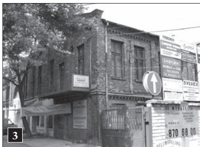
3 Hala produkcyjna Zakładów „Juty”. Stan z 2008 r.
