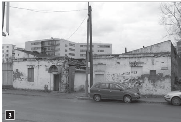
1 Wjazd od ul. Burakowskiej. Stan z 2009 r.
