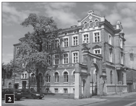
2 Budynek administracyjny i brama. Stan z 2008 r.
