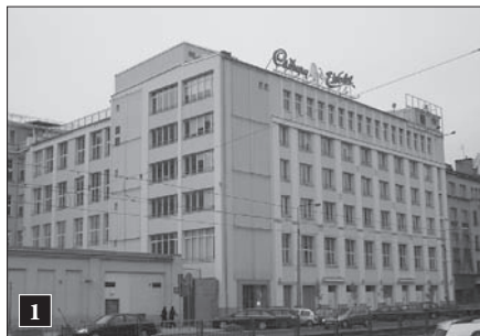
1 Budynek biurowy. Stan z 2009 r.
