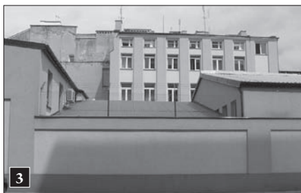
1 Widok z narożnika ulic Belgijskiej i Wygoda. Stan z 2009 r.
