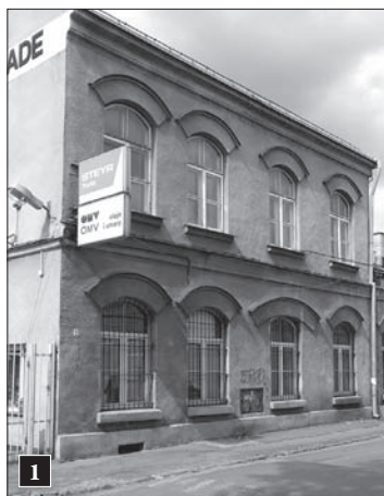
1 Widok od ul. Lubelskiej. Stan z 2009 r.
