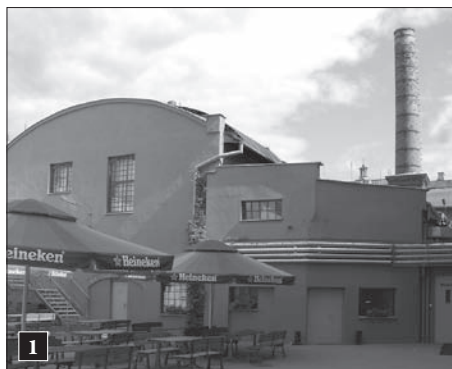
1 Widok hali od strony dziedzińca. Stan z 2008 r.
