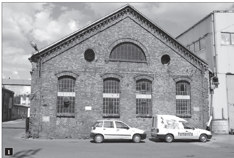
1 Główna hala produkcyjna. Widok od podwórza. Stan z 2008 r.
