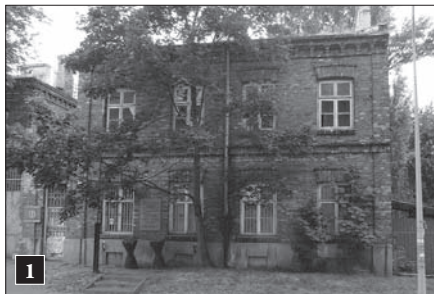
1 Budynek biurowo-mieszkalny od ul. Objazdowej. Stan z 2009 r.
