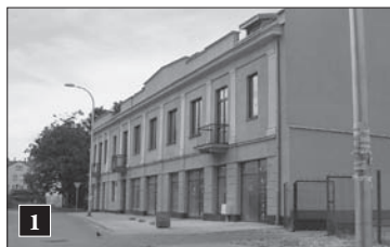
1 Budynek biurowo-mieszkalny. Stan z 2008 r. po otynkowaniu.
