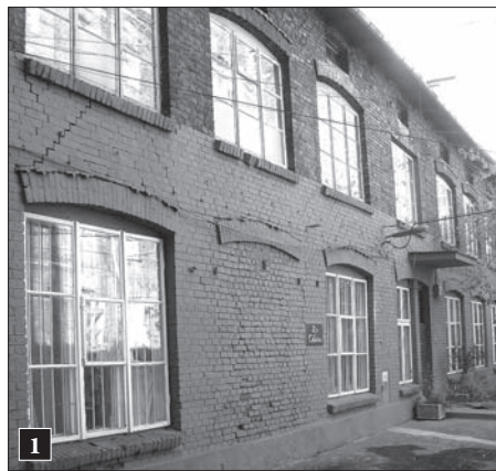
1 Widok elewacji frontowej. Stan z 2009 r.
