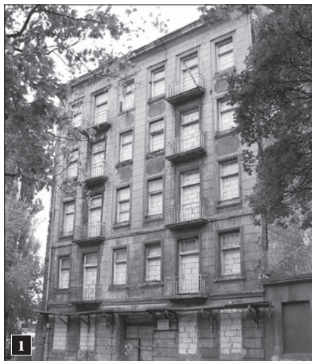
1 Nieistniejąca kamienica przy ul. Spokojnej 3. Stan z 2008 r.
