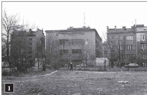
1 Budynki mieszkalne i hala przed remontem. Zdjęcie z 1983 r.
