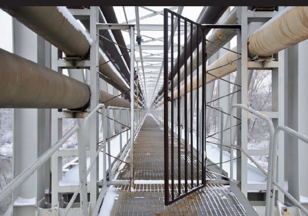
Elektrociepłownia na Żeraniu (fot. Monika i Filip Miłowscy)
