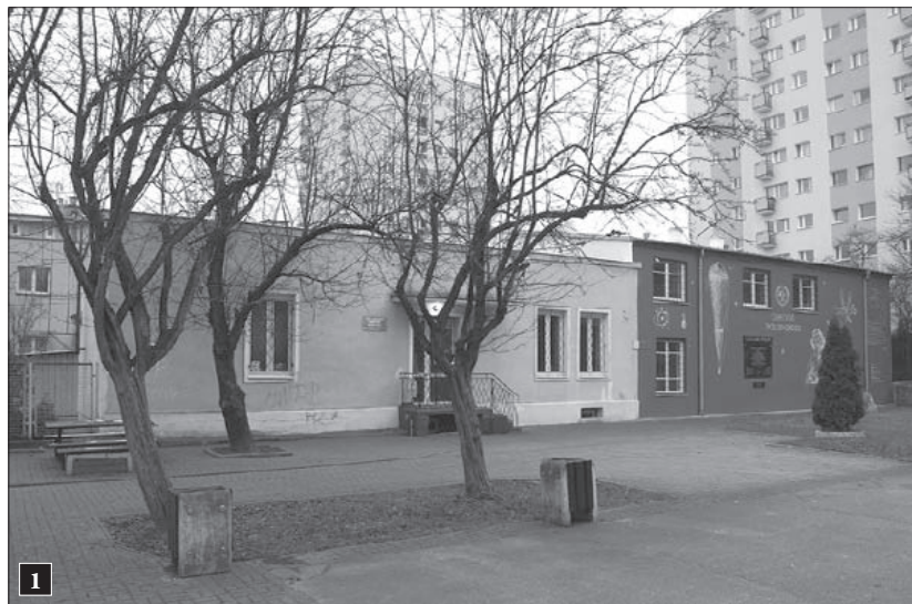
1 Widok d. zakładów ze sgrafitem; fot. 2010 r.
