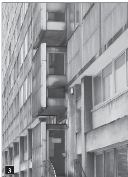
3 Budynek biurowy – fragment elewacji tylnej; fot. 2010 r.
