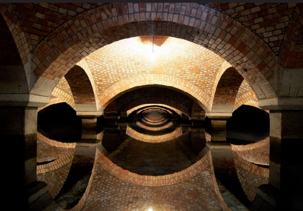
Zbiorniki filtrów powolnych w Stacji Filtrów (fot. Michał Krasucki)
