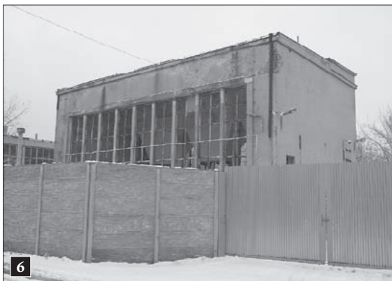
6 Kotłownia; fot. 2010 r.
