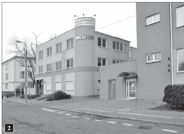
1 Widok od strony Hali Kopinskiej; fot. 2010 r.
