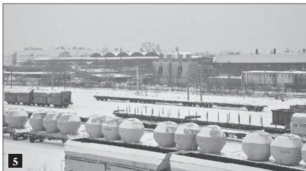
5 Widok ogólny; fot. 2010 r.
