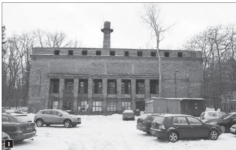
1 Widok ogólny kotłowni; fot. 2010 r.
