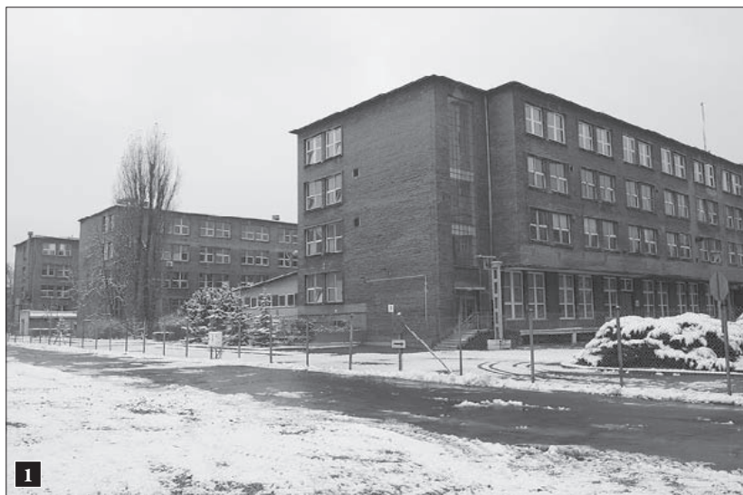
1 Widok ogólny; fot. 2010 r.
