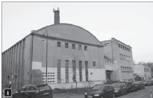
1 Widok ogólny, fot. 2010 r.
