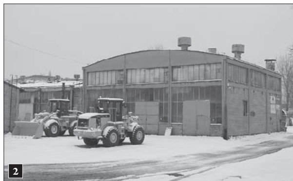
1 Hala produkcyjna; widok od ulicy; fot. 2010 r.
