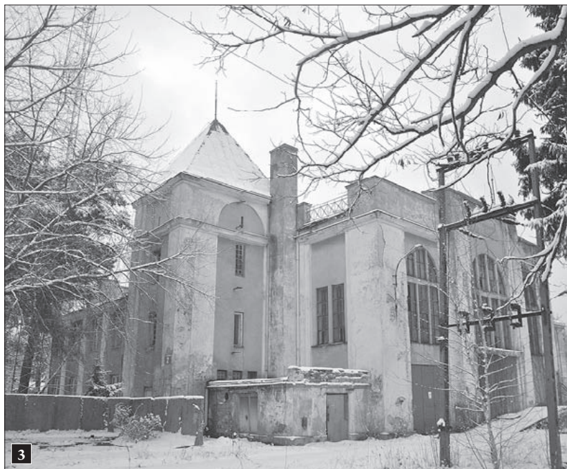
3 Widok ogólny; fot. 2010 r.
