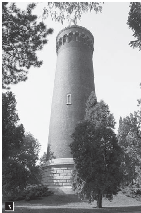
3 Wieża ciśnień; fot. 2010 r.
