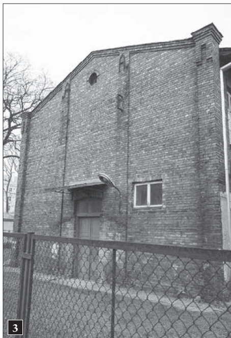
3 Elewacja zachodnia budynku; fot. 2010 r.
