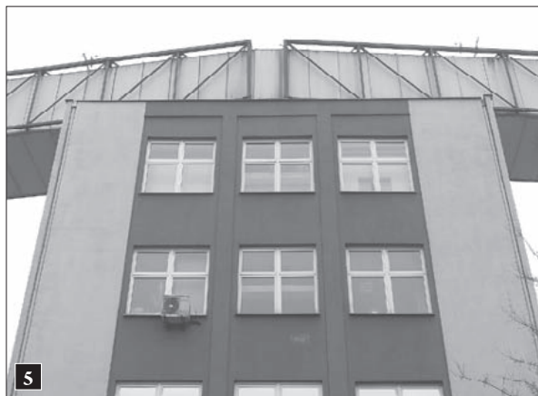
5 Budynek przy ul. Kasprzaka, fragment; fot. 2010 r.
