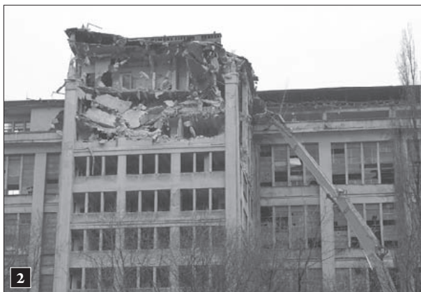
1 Widok ogólny; fot. 2009 r.
