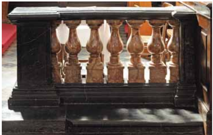
195. Warszawa, kościół franciszkanów-reformatów, kaplica św. Antoniego Padewskiego/Załuskich, balustrada wejściowa, XVII/XVIII w., wapień Dębnik i kalcyt żyłowy Różanka Paczółtowicka , wyk. nieustalony warsztat dębnicki (atryb.)
