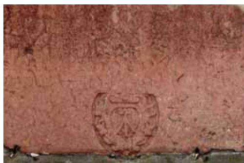
62. Warszawa-Stare Miasto, archikolegiata, tablica fundacyjna budowy spichlerza Wojciecha Baryczki przy ul. Brzozowej nr 22, 1629, wapień olandzki Dälje , proj. i wyk. nieustalony warsztat z Warszawy (atryb.)
