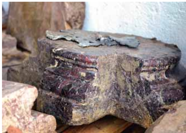
130. Warszawa, Pałac Kazimierzowski, baza kolumny z loggii frontowej lub ogrodowej z widoczną fugą ołowianą, lata 30. XVII w., marmur Verde alpi/alpina z Valle d'Aosta, wyk. nieustalony warsztat z Niderlandów Hiszpańskich, Gdańska lub nadworny z Warszawy (atryb.), fot. H. Kowalski
