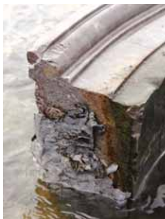
138. Warszawa, Pałac Kazimierzowski, odcinek archiwolty arkady loggii frontowej z widocznym żelaznym bolcem montażowym oblanym ołowiem, fot. H. Kowalski
