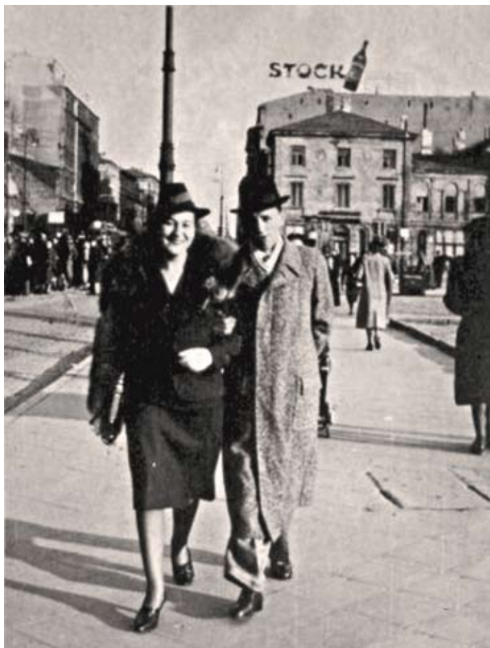
100. Uszkodzony neon „Stocka” (brak napisów po prawej stronie butelki) – Marszałkowska 99. Neon „Spiessa” na widocznej na bliższym planie willi Marconiego został już rozebrany. Stan ok. 1940.
