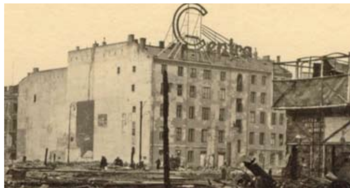
28. Neon „Centra” w październiku 1939. Widoczne uszkodzenia – brak elementu graficznego (baterii).
