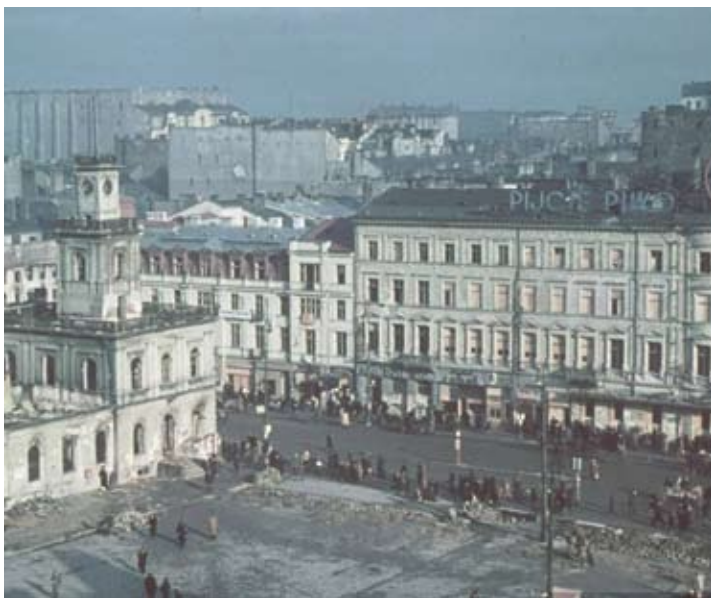
18. Neon „Żywca” w październiku 1939, w początkowym stadium rozbiórki.
