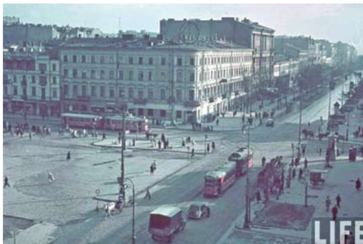
101. Demontaż neonu „Żywca” – Marszałkowska 100, październik 1939.
