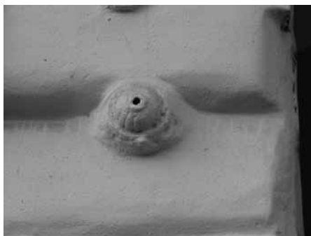
Uchwyt lampy skryty pod grubą warstwą farby (fot.K. Jaszczyński)
