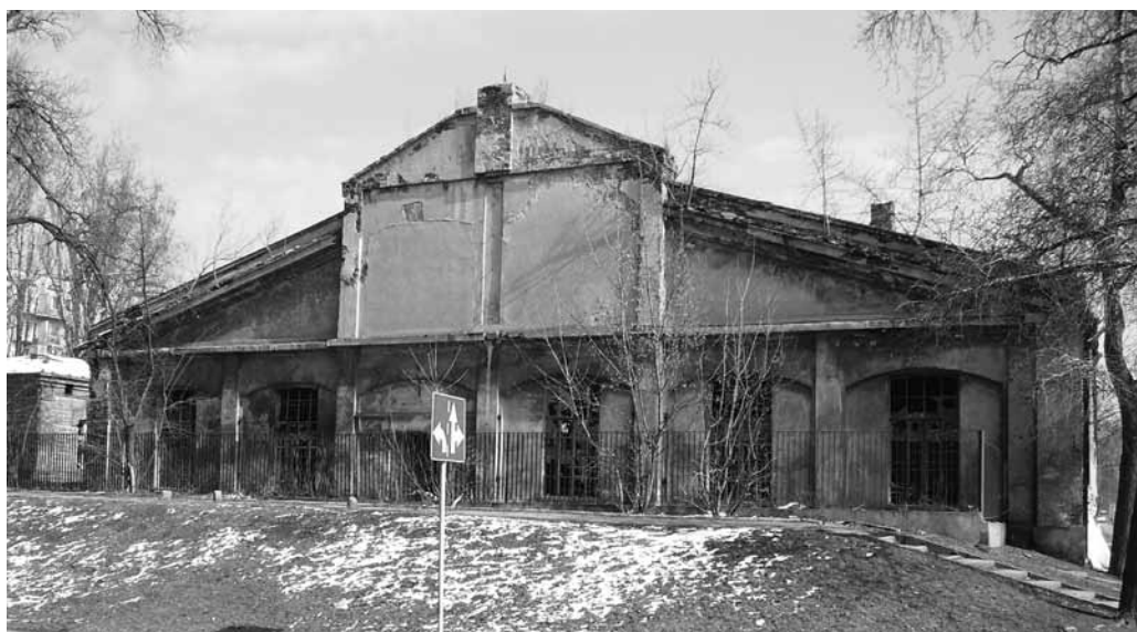
Budynek parowozowni przed wyburzeniem (fot. J. Sujecki)
