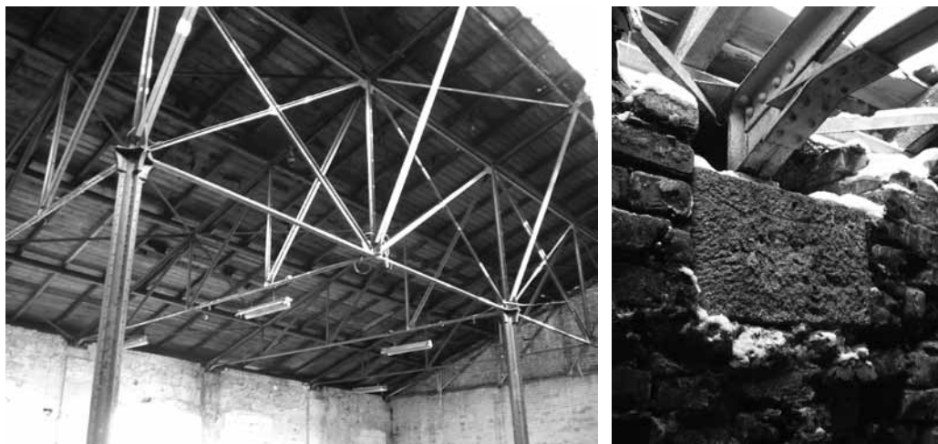
Konstrukcja dachowa parowozowni (fot. J. Sujecki)
