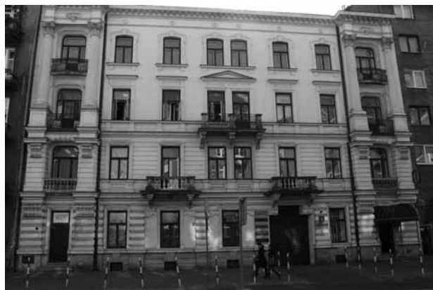
Odrestaurowana elewacja domu Białobrzaska 5 (fot.K. Jaszczyński)
