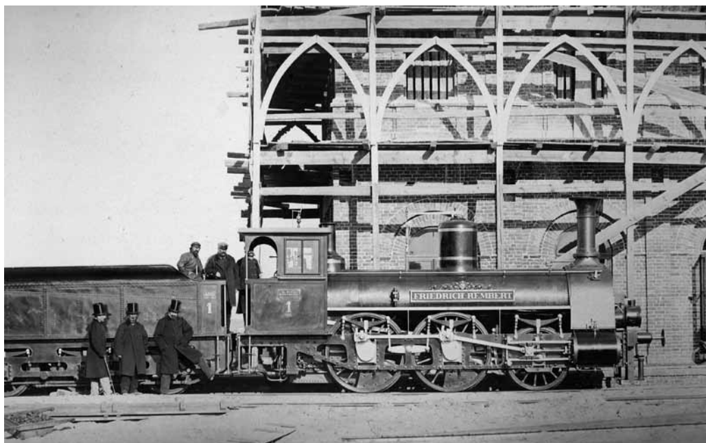
Budowa Dworca Terespolskiego 1866 r. – fot. archiwalna
