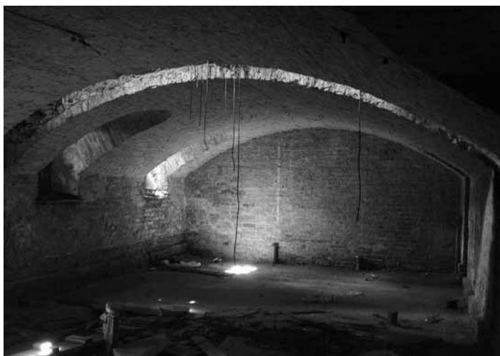
Piwnica z kolebkowym sklepieniem w piwnicy przy ul. Kijowskiej 5 (fot. J. Sujecki)
