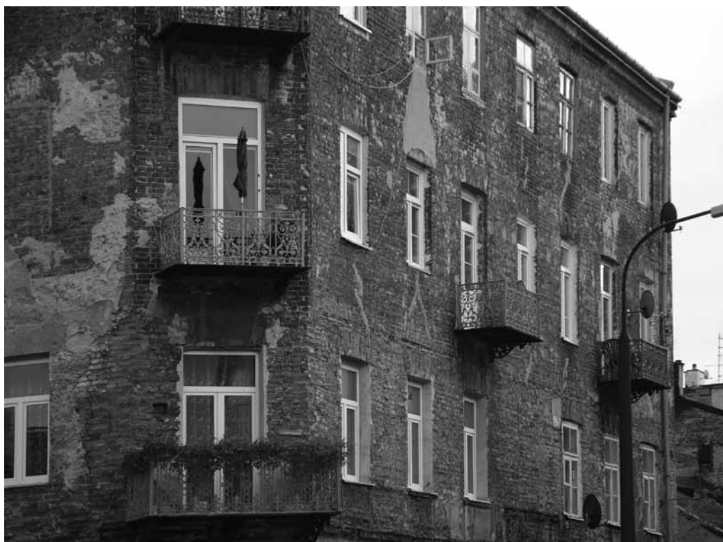
Kamienica na skrzyżowaniu ul. Strzeleckiej i Śródkowej – stan obecny (fot. M. Krasucki)
