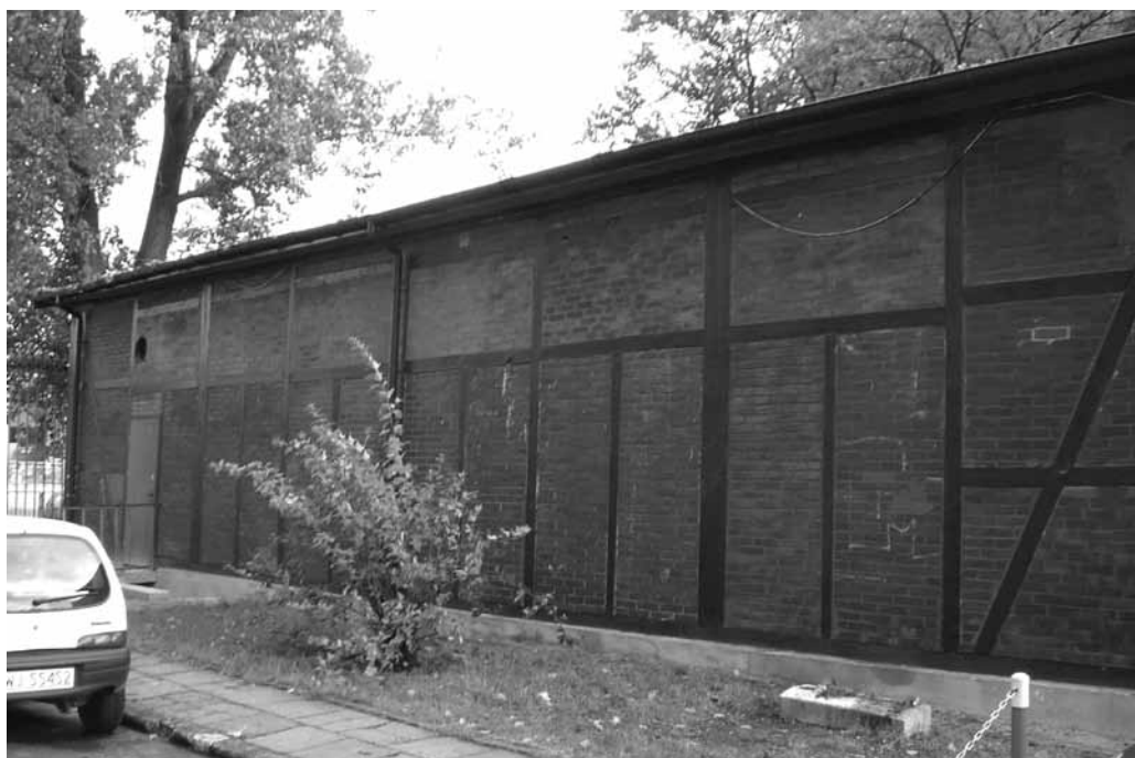
Budynek magazynowy Dworca Wileńskiego (fot. J. Sujecki)
