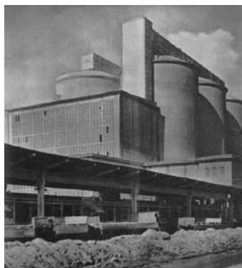
118. Przemiałownia cementu [wg: „Architektura” 1957]
