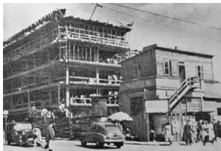
191. Budowa skrzydła „B” od ul. Nowogrodzkiej [wg: „Stolica” 1950]
