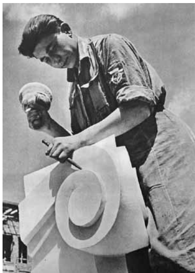
46. Jan Wilk wykuwa kamienny kapitel na budowie MDM, 1950 r. [wg: Jankowski 1955, fot. E. Kupiecki]
