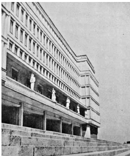
157. Gmach KC PZPR – elewacja pld. z nieistniejącymi już obecnie kariatydami [wg: „Stolica” 1955]
