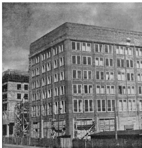
186. Biurowiec Metalexportu – stan budowy we wrześniu 1952 r. [wg: Garliński 1953]
