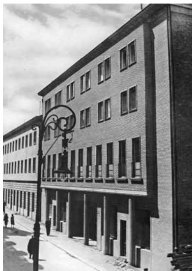
44. Cegła gruzobetonowa na elewacji budynku Warty, ul. Ordynacka 14/16 [wg: Bierut 1950, fot. A. Gąsiewicz]
