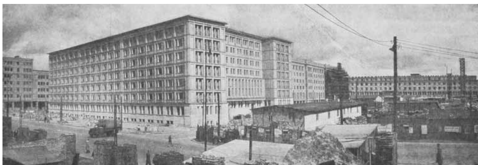
179. Gmach Ministerstwa Górnictwa w budowie – widok od narożnika ul. Hożej, 1952 r. [wg: Garliński 1953]
