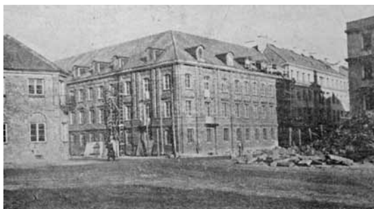
209. Narożny segment biurowca przy ul. Senatorskiej 10 [wg: „Stolica” 1951]
