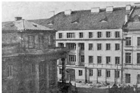
208. Segment biurowca przy ul. Senatorskiej 10 [wg: „Stolica” 1951]
