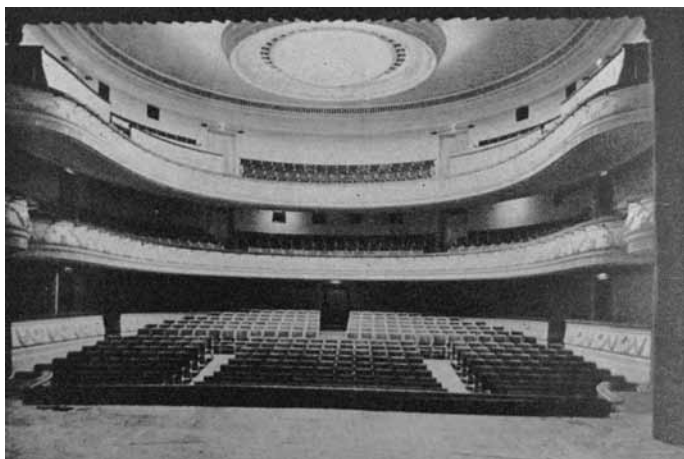
133. Widownia Teatru Dramatycznego [wg: „Architektura” 1955]
