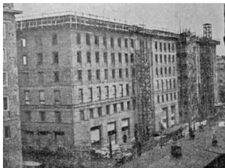
195. Budowa biurowca CZBM, wiosna 1952 r. [wg: „Stolica” 1952, fot. S. Roszczyk]
