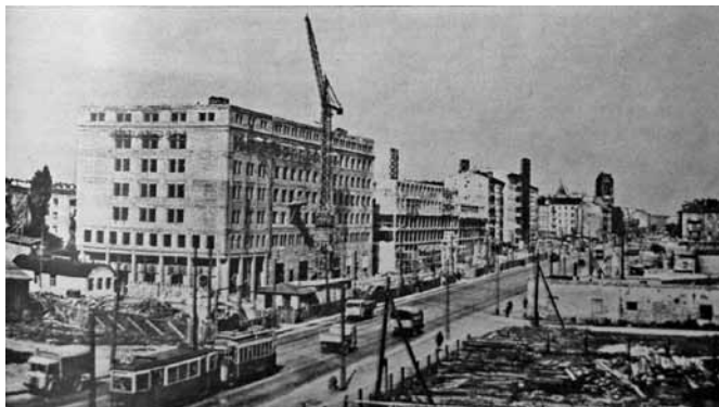
370. Ochota I – budowa bloków przy ul. Grójeckiej [wg: „Stolica” 1953]
