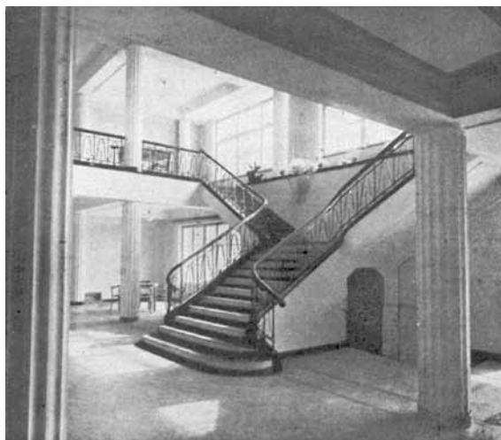
243. Dom Społeczny przy ul. Grenadierów – hol i klatka schodowa [wg: „Architektura” 1952]
