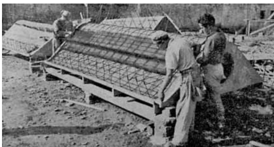
47. Układanie prefabrykowanego zbrojenia w formie do wylewania elementów stropów [wg: „Architektura” 1952]
