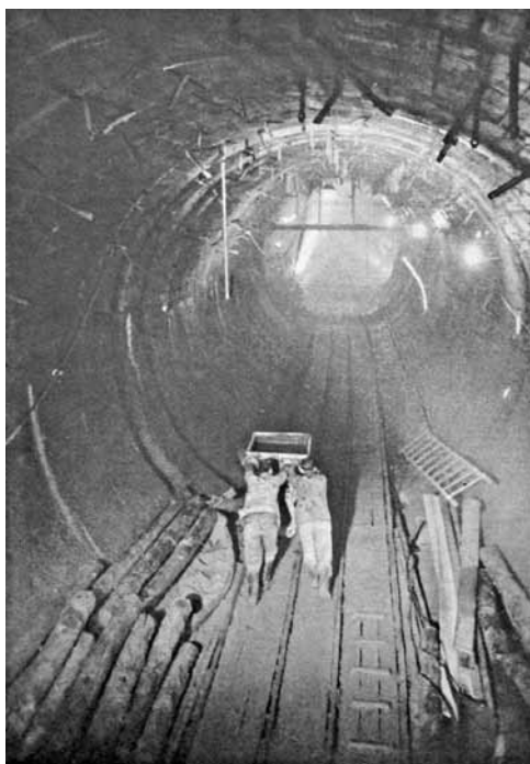
147. Roboty w tunelu metra [wg: „Stolica” 1956, fot. Z. Siemaszko]
