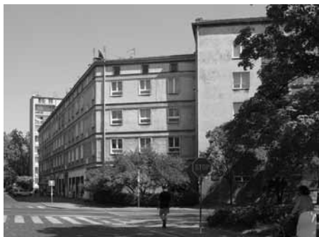
38. Bloki przy ul. Opaczewskiej pozbawione zamierzonych elementów wystroju elewacji [fot. J. Zieliński, 2005]
