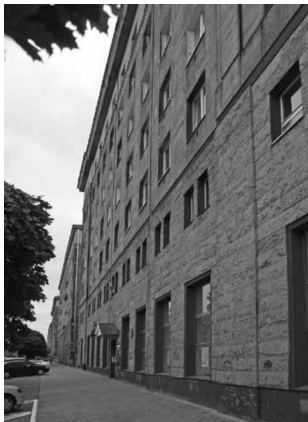
371. Ochota I – wielkomiejska zabudowa ul. Białobrzeskiej [fot. J. Zieliński, 2008]
