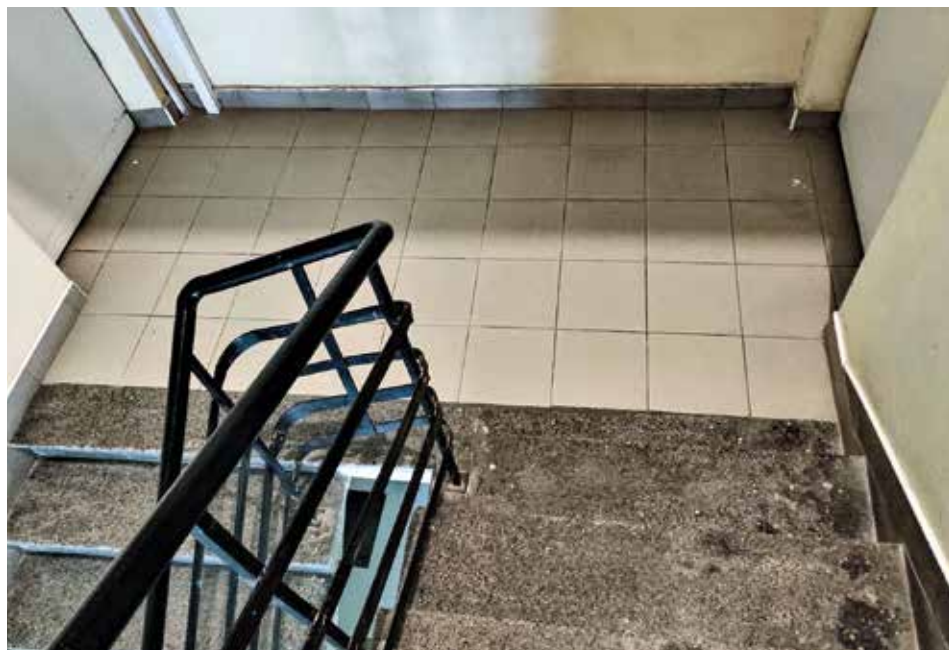
Podesty klatki schodowej kamienicy przy ul. Zgoda 5 – z płytkami historycznymi zachowanymi na ostatniej kondygnacji oraz płytkami współczesnymi na niższych piętrach. Fot. K. Komar-Michalczyk, 2021
