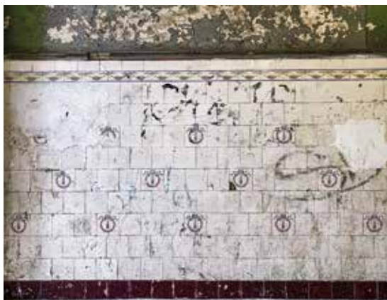
Okładzina ceramiczna ścian przejazdu bramnego kamienicy przy ul. Brzeskiej 20. Fot. W. Kmieć
