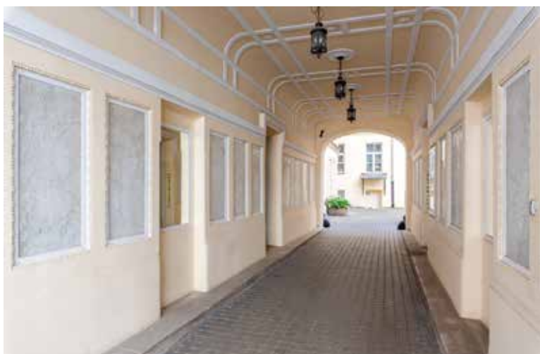
Nawierzchnia przejazdu bramnego kamienicy przy ul. Koszykowej 57 – pokryta tzw. kostką Bauma. Fot. K. Diks
