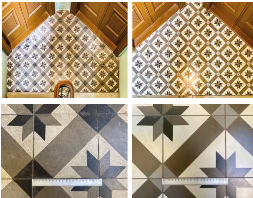
Posadzka podestów głównej klatki schodowej kamienicy przy ul. Brzeskiej 18 – płytki wykonano wg kształtu, wymiarów i wzoru pierwotnych płytek cementowych (z niewielkimi różnicami w rozkładzie kolorów). Fot. W. Kmieć
