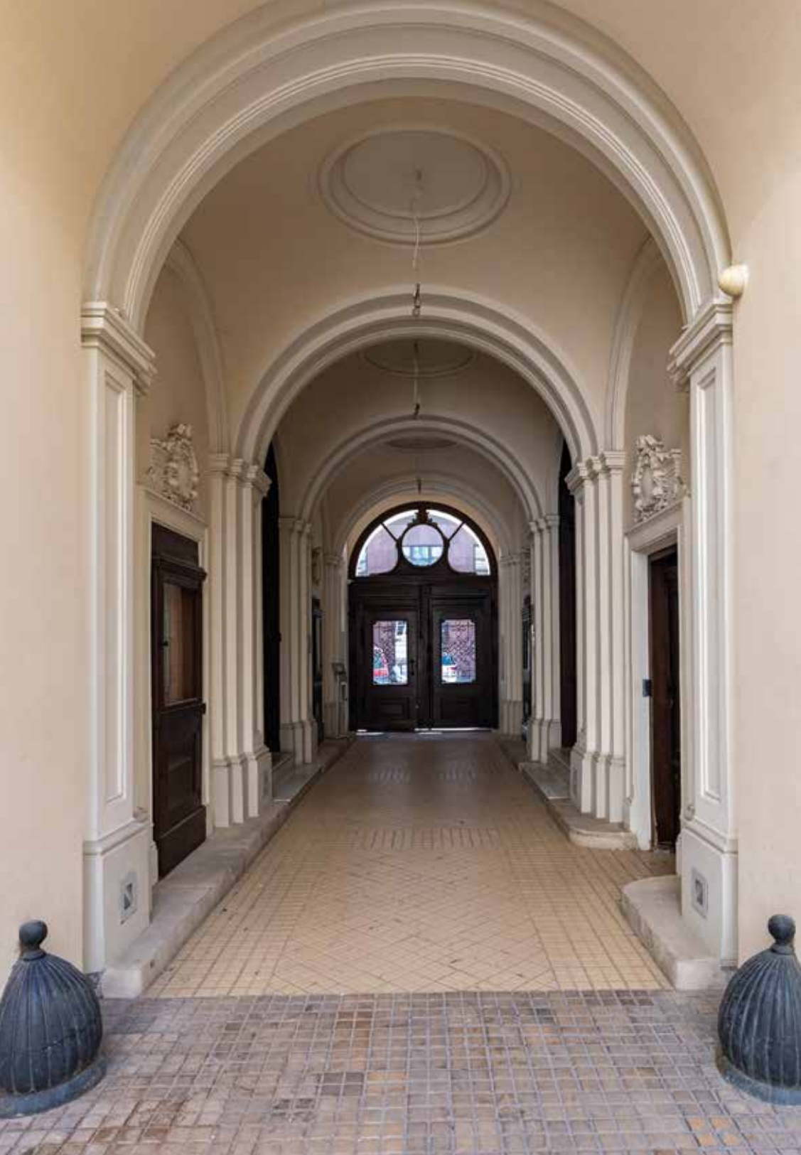
Nawierzchnia przejazdu bramnego kamienicy przy ul. Nowogrodzkiej 44 – przy wrotach oraz u wylotu na podwórze zachowane pierwotne płytki bramowe, środek wyłożony współczesnymi płytkami o takich samych rozmiarach i wg wzoru stosowanego w XIX/XX w. Fot. K. Diks
