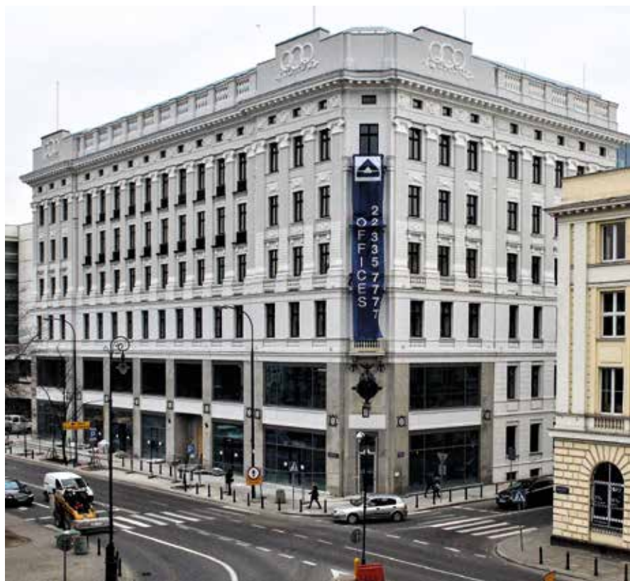
Dawny dom dochodowy hr. Krasieńskich przy ul. Mazowieckiej 20 (1907-1910, proj. Jan Heurich mł. i Artur Goebel), stan po powojennej rozbudowie skrzydła od Mazowieckiej i współczesnej renowacji. Fot. J.S. Majewski
