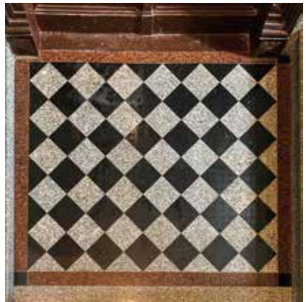
Podesty głównej klatki schodowej kamienicy przy ul. Targowej 61 – stan przed skuciem historycznych cementowych płytek oraz w trakcie „remontu” (2019) i współcześnie, tj. z pokryciem z płytek granitowych niemających nic wspólnego z pierwotnymi (2024). Fot. K. Komar-Michalczyk, W. Kmieć
