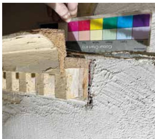
W trakcie badań konserwatorskich kamienicy przy ul. Jasnej 17 pod drewnianym gzymsem odnaleziono fragmenty tapety najprawdopodobniej z XIX w. Fot. K. Onisk, 2023
