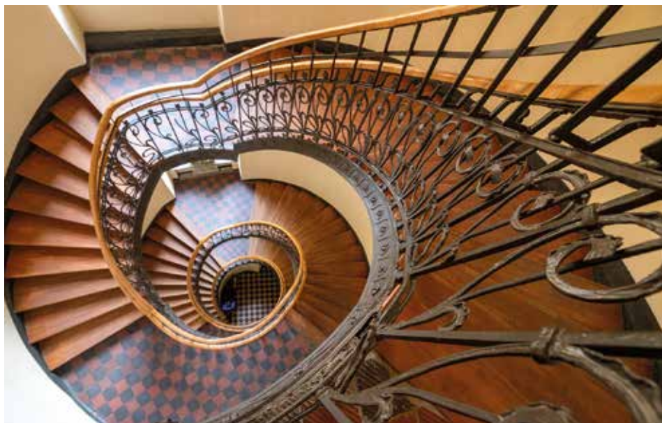
Płytki posadzkowe z 1967 r. na podestach głównej klatki schodowej kamienicy przy ul. Kłopotowskiego 38. Fot. K. Diks
