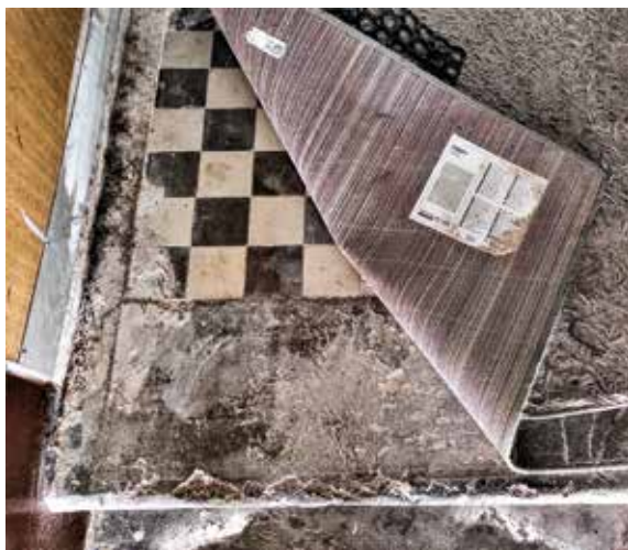
Zastonięte pierwotne posadzki głównej klatki schodowej kamienicy przy ul. Miedzianej 3. Fot. K. Komar-Michalczyk, 2021
