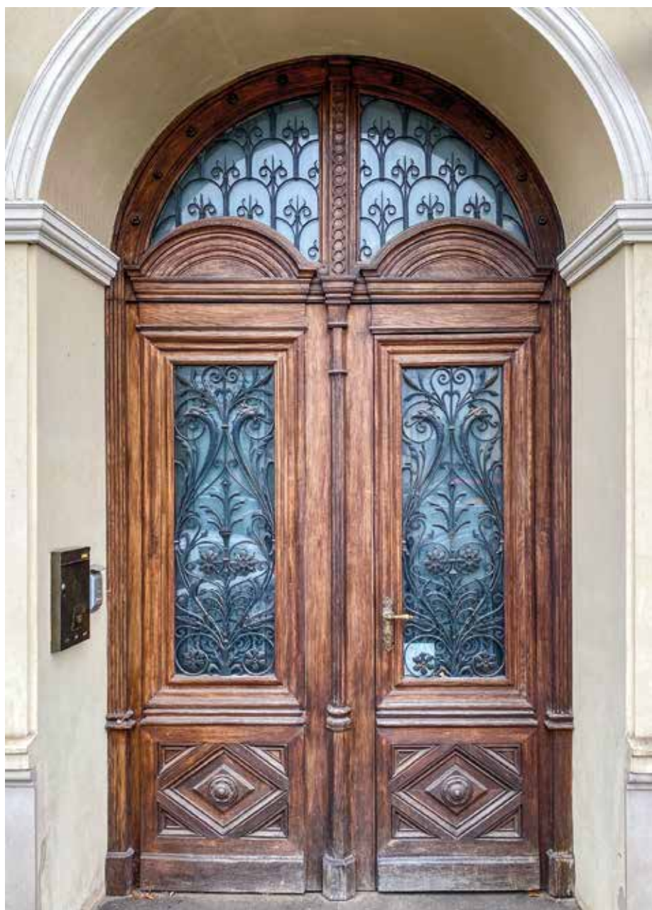
Dobry przykłady rekonstrukcji drzwi przejazdu bramnego w d. pałacu Janaszów przy ul. Zielnej 49. Po 17 latach użytkowania drzwi wymagają tylko odświeżenia powłoki malarskiej. Fot. W. Kmieć
