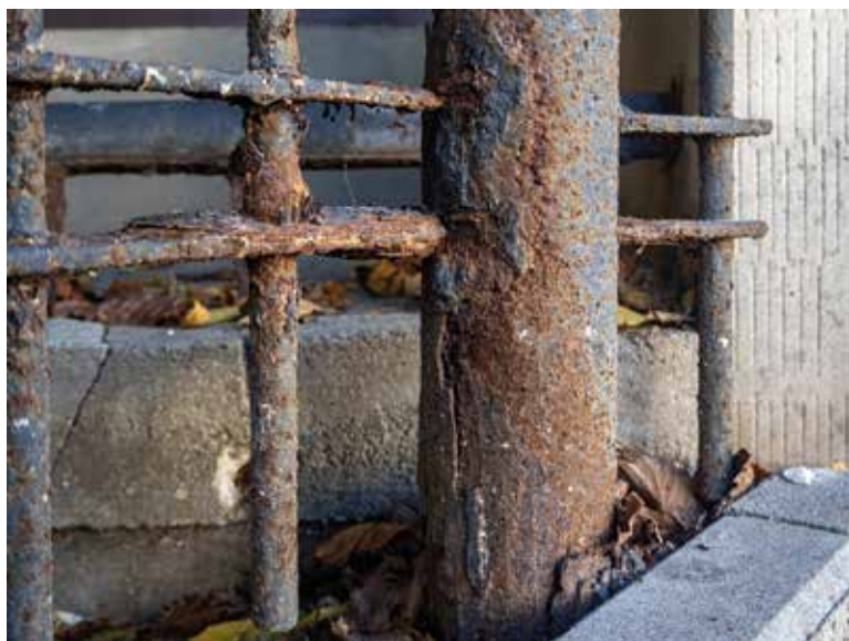
Fragment ogrodzenia przy Pałacu Staszica od strony ulicy Kopernika – rezultat całkowitego zaniedbania obiektu. Fot. K. Diks
