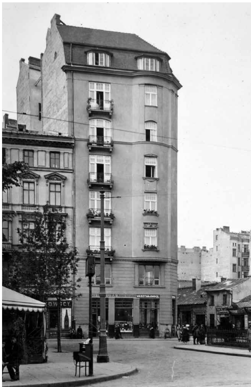
Dom czynszowy przy ul. Hożej 1 (1914), stan na 1916 r. Fot. IS PAN, Zbiory fotografii i rysunków pomiarowych IS PAN, Warszawa 1915-1978, sygn. R_63485
