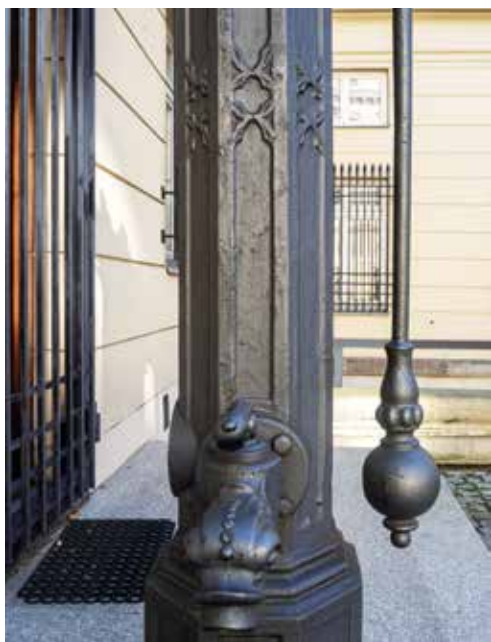
Pompa wodna na dziedzińcu pałacu Czapskich przy ul. Krakowskie Przedmieście 5 – nieodpowiednie przygotowanie obiektu do malowania: nieusunięta warstwa starej farby. Fot. K. Diks
