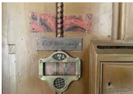
Stolarka drzewiwa klatki schodowej kamienicy przy ul. Targowej 84. W odkrywkach widoczny jest malarski mazerunek, czyli malarska imitacja drewna. Fot. K. Diks, K. Onisk
