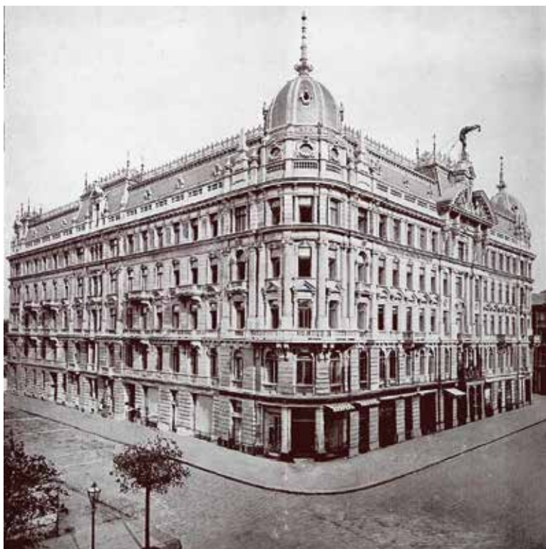
Dom dochodowy Towarzystwa Ubezpieczeń „Rosja”, ul. Marszakowska 124; „Przegląd Techniczny”, 1901, nr 27
