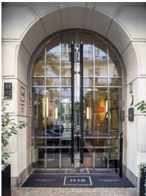
Widok przejazdów bramnych zamkniętych nowymi drzwiami ze szkła i żelaznymi szklonymi – za pomocą których ukazano cechy dekoracyjne wnętrza. Po lewej ul. Nowy Świat 7, po prawej ul. Poznańska 15. Fot. A. Cichy, K. Diks
