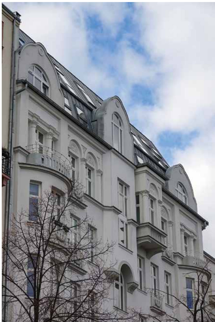
Kamienica przy ul. Flory 3 (1913), fragment zrekonstruowanej w latach 2014-2016 partii zwieńczenia i dachu ze świadomym uproszczeniem modelunku wystroju oraz wykorzystaniem poddasza na funkcje użytkowe poprzez podniesienie kąta nachylenia połaci dachowych w trakcie podwórzowym – stan na 2020 r. Fot. P. Kilanowski
