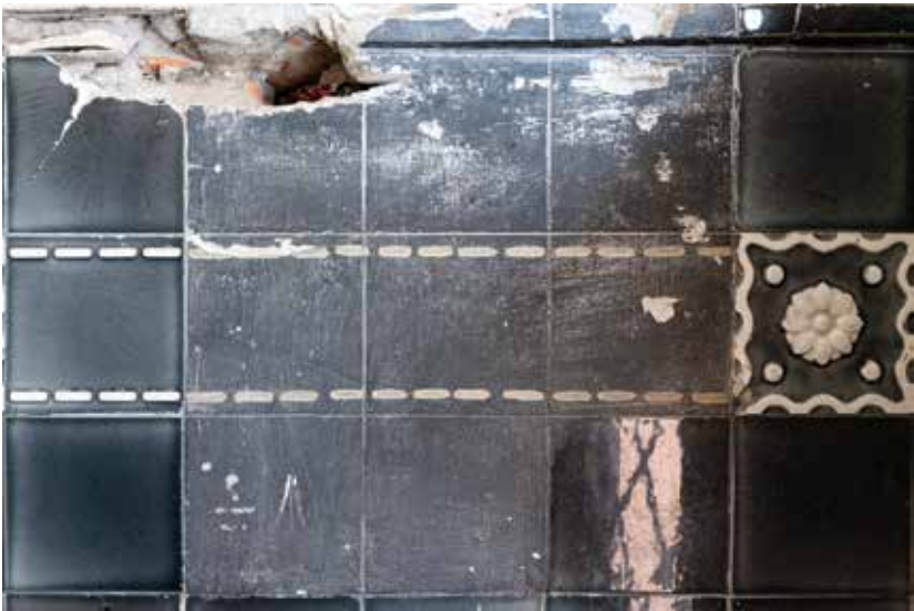
Przejazd bramny kamienicy przy ul. Siennej 45 - widok ogólny i zbliżenia na fragmenty okładziny ceramicznej zamalowane wtórnie farbą. Fot. K. Diks
