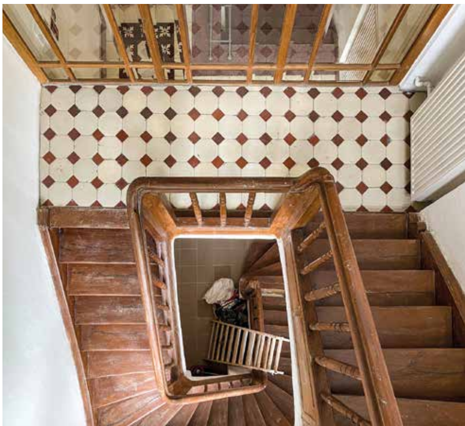
Podest kuchennej klatki schodowej przylegającej do głównej klatki schodowej (z przejazdu bramnego) kamienicy przy ul. Noakowskiego 16 – z zachowanymi płytkami historycznymi. Fot. W. Kmieć
