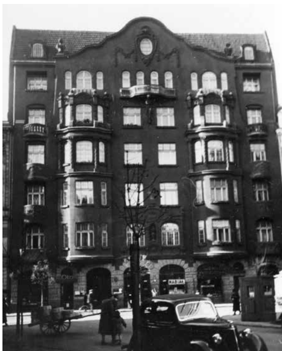
Kamienica przy ul. Mokotowskiej 41 (1911), stan na 1938 r. Fot. APW, 3: Zbiór Referatu Gabarytów, Warszawa 1935- -1942, sygn. 4690
