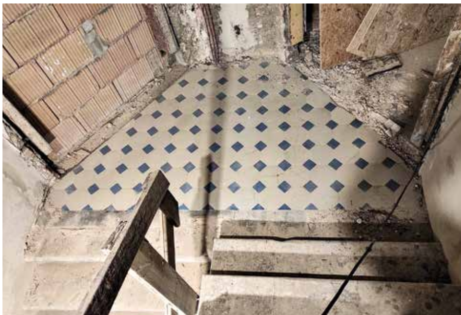
Podest klatki schodowej pośrodku skrzydła od strony ulicy Żelaznej (z wejściem od podwórza) w kamienicy przy ul. Złotej 83 / róg Żelaznej – ułożony z płytek odczyszczonych i/lub przeniesionych z rozebranej klatki schodowej z przejazdu bramnego od strony ulicy Złotej. Fot. K. Komar-Michalczyk, 2021
