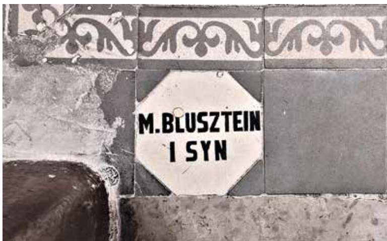
Płytką sygnaturową przedsiębiorstwa „M. Blusztajn i Syn” w oficynie poprzecznej kamienicy przy ul. Górskiego 3, podest przed biegiem wyrównawczym schodów. Fot. K. Komar-Michalczyk, 2021
