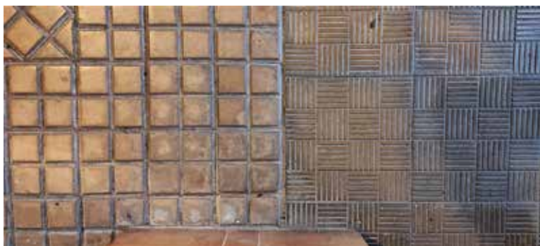
Nawierzchnia przejazdu bramnego kamienicy przy ul. Widok 16 – przy wrotach bramy płytki współczesne, o innych wymiarach i fakturze. Fot. K. Komar-Michalczyk, 2021
