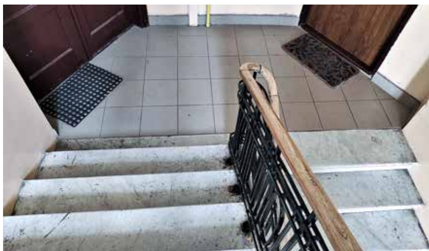
Podesty głównej klatki schodowej w kamienicy przy ul. Chłodnej 34 – z płytkami pierwotnymi i współczesnymi, niemającymi nic wspólnego z pierwotną okładziną.
