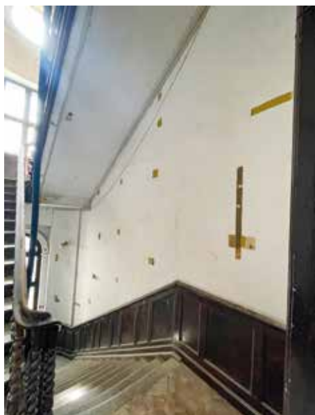
Główna klatka schodowa kamienicy przy ul. Jasnej 17, stan z 2023 r. W trakcie badań wykonano bardzo dużo odkrywek stratygraficznych (widoczne na fotografii w formie geometrycznych sond), w celu określenia zakresu i stanu zachowania polichromii. Fot. K. Onisk, 2023
