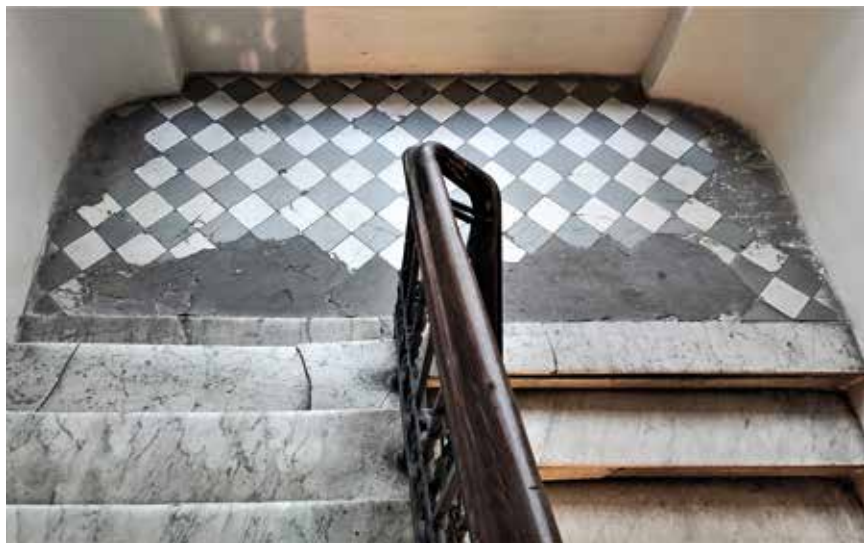
Uzupełnione wylewką betonową miejsca ubytków po płytkach – kamienica przy ul. Sienkiewicza 4. Fot. K. Komar-Michalczyk, 2021
