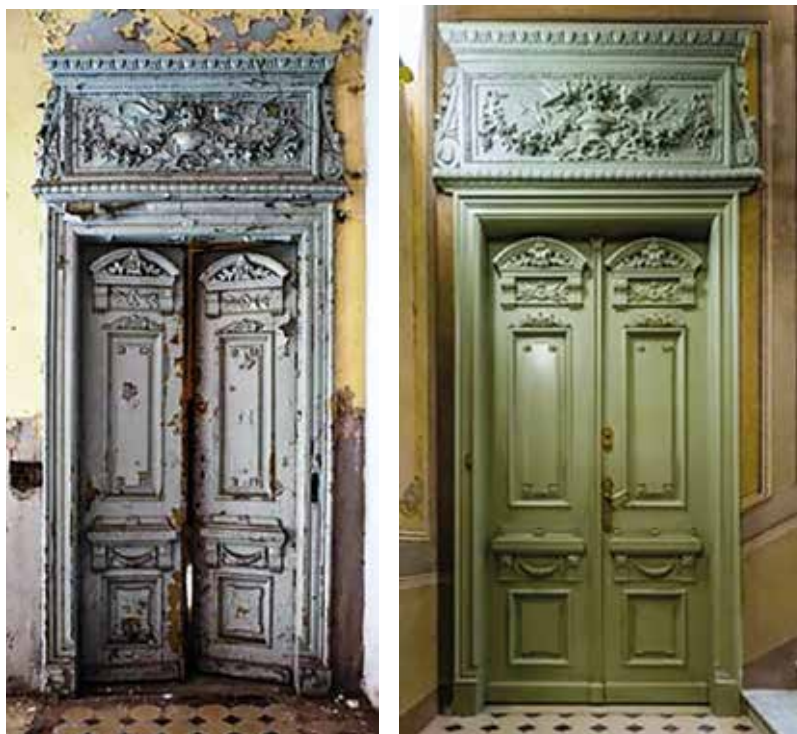
Klatka schodowa w kamienicy przy ul. Foksal 15. Na fotografiach ukazano drzwi drewniane z supraportą – w stanie przed pracami restauratorskimi oraz po restauracji. Kolorystykę przywrócono po wykonaniu badań stratygraficznych warstw malarskich. Fot. za: M. Stacherski, Przywrócone piękno dawnej Warszawy. Niezwykła metamorfoza 120-letnich kamienic Foksal 13/15 (online), 29.09.2020, https://www.whitemad.pl/foksal_13-15_metamorfoza/ (dostęp: 10.05.2024)
