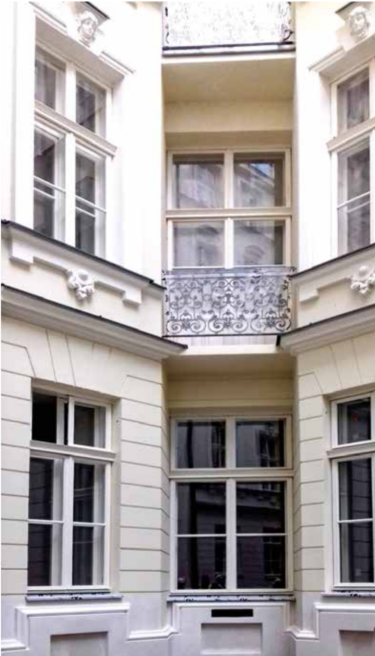
Fragment elewacji podwórzowej kamienicy przy ul. Foksal 13 po remoncie, odtworzona balustrada balkonu
