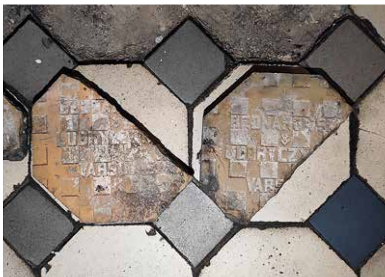
Rewersy płytek przedsiębiorstwa „Bednarowski i Lubryczyński” – różne warianty znaku firmowego – u góry płytki cementowe (ul. Twarda 28, 1896, nadbudowa i rozbudowa 1911-1913*), u dołu ceramiczne (ul. Dobra 31, 1912-1913)
