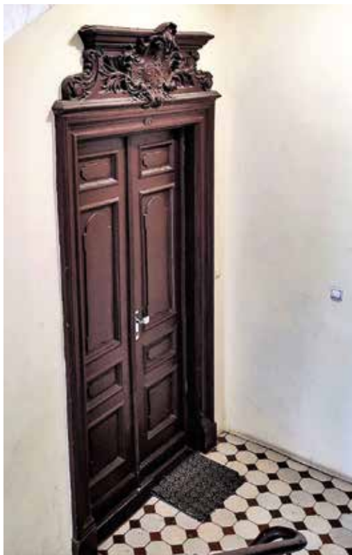
Drzwi do mieszkania na paradnej klatce schodowej w kamienicy przy ul. Hożej 27 (1898-1900, proj. Karol Kozłowski), zwieńczone rozbudowanym, neobarokowym naczółkiem (supraportą). Fot. J.S. Majewski
