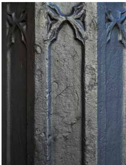
Pompa wodna na dziedzińcu pałacu Czapskich przy ul. Krakowskie Przedmieście 5 – nieodpowiednie przygotowanie obiektu do malowania: nieusunięta warstwa starej farby. Fot. K. Diks
