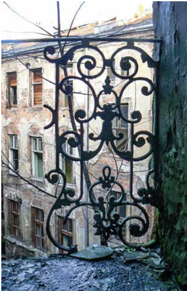
Jedno z przęseł balustrady balkonu od strony podwórza kamienicy przy ul. Foksal 13
