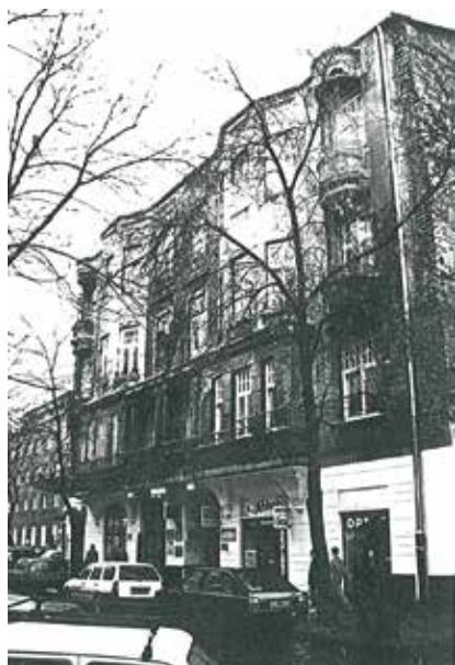
Dom dochodowy przy ul. Emilii Plater 25 (1912), częściowo uszkodzony, pozbawiony ostatnich dwóch kondygnacji, szczytu i poddasza – stan na 1997 r. Fot. J. Rembiewska
