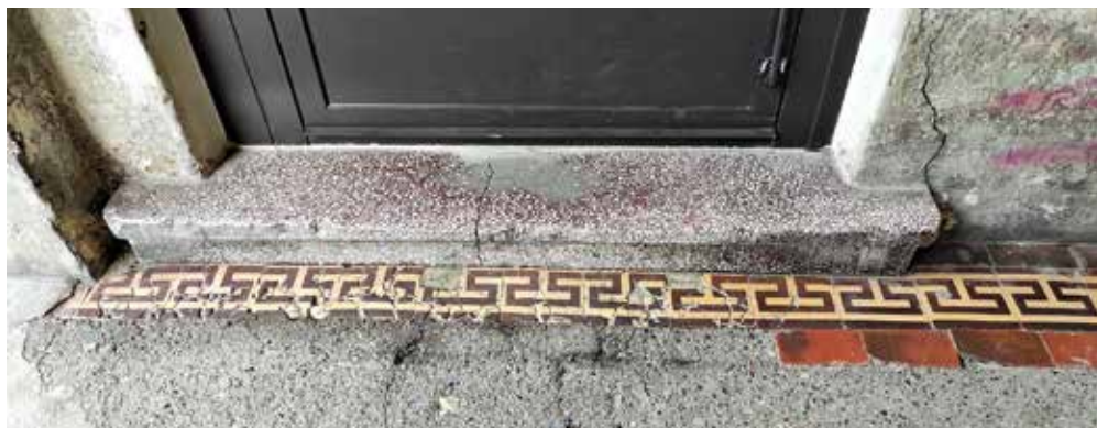
Uzupełnione wylewką ubytki w nawierzchni przejazdu bramnego kamienicy przy ul. Miedzianej 4 i zachowane fragmenty pierwotnej posadzki przejazdu. Fot. K. Komar-Michalczyk, 2021
