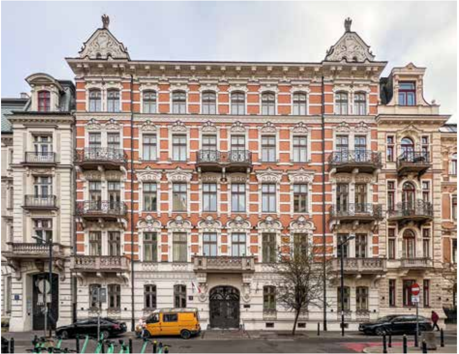
Elewacja frontowa kamienicy przy ul. Foksal 13 po wykonaniu prac remontowych, z odtworzeniem detali. Fot. W. Kmieć
