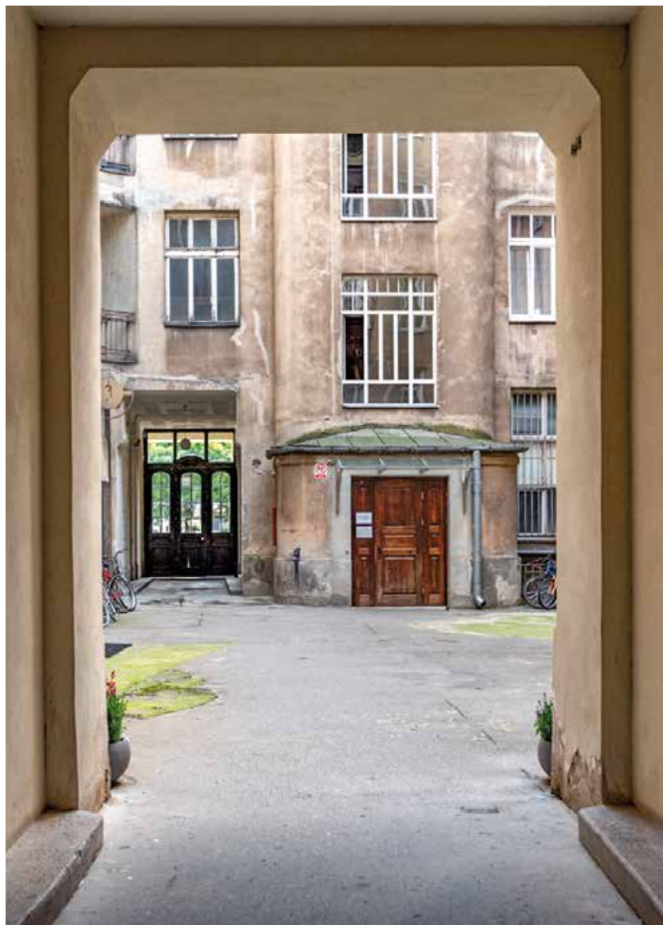
Drugi przejazd bramny kamienicy przy ul. Chłodnej 20. Fot. K. Diks
