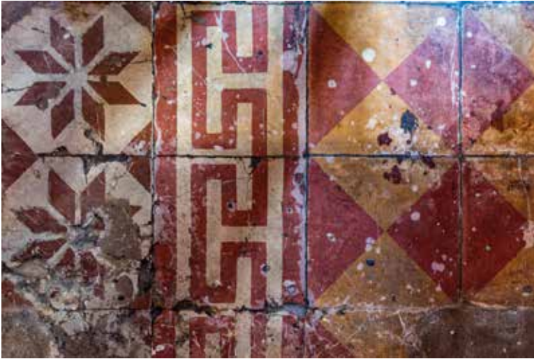
Zastąpiona przezroczystym linoleum/folią (?) posadzka z płytek cementowych w lokalu handlowym w parterze kamienicy przy ul. Pięknej 54. Fot. K. Diks
