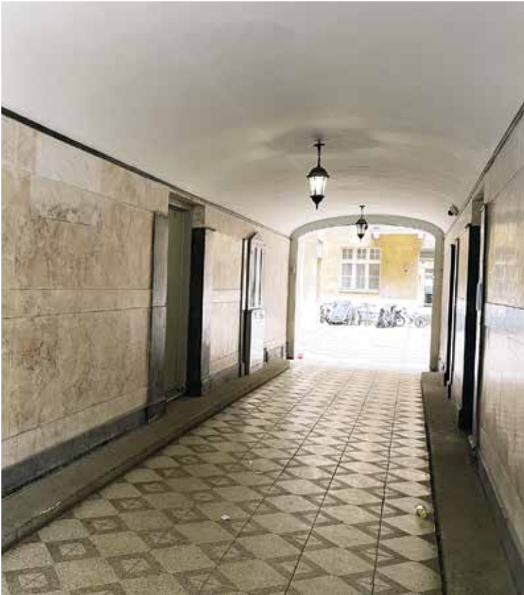
Przejazd bramny kamienicy przy ul. Noakowskiego 10, obłożony płytami stiukowymi imitującymi kamień. Niektóre detale pomalowano brązą – miały udawać powierzchnie złocone. Fot. K. Onisk
