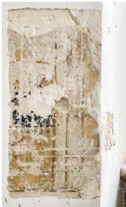
Główna klatka schodowa kamienicy przy ul. Jasnej 17, stan z 2023 r. Odkrytki ukazują spodnią warstwę dekoracji malarskiej. Aby przed remontem określić rodzaj dekoracji, należy przeprowadzić badania. Fot. K. Onisk, 2023
