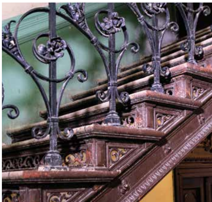
Fragment metalowych schodów w paradnej klatce kamienicy Adolfa Daaba przy ul. Wilczej 32 (1897-1898). Fot. J.S. Majewski
