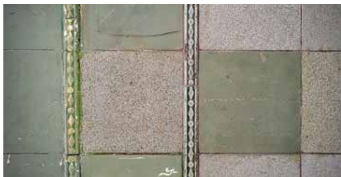
Podesty półpięter klatki schodowej od placu Dąbrowskiego kamienicy przy ul. Kredytowej 9 – z płytkami historycznymi (tzw. gorsecikami) zachowanymi na ostatniej kondygnacji oraz płytkami współczesnymi na niższych piętrach. Fot. K. Komar- Michalczyk, 2021
