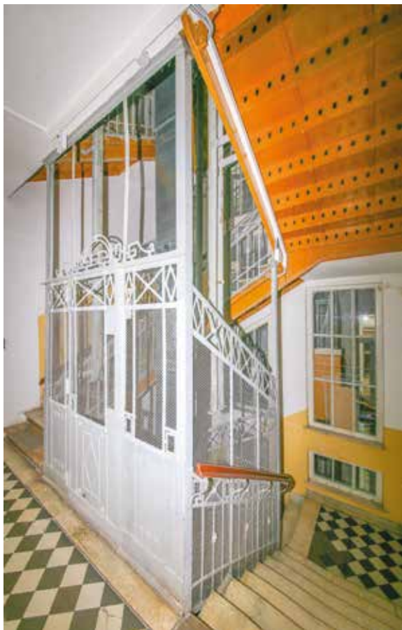
Secesyjny szyb windy na paradnej klatce w skrzydle frontowym kamienicy w al. „Solidarności” 93 (1913). Fot. W. Kmieć
