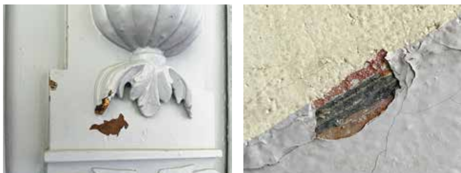
Detale z klatki schodowej kamienic przy ul. Wileńskiej 19 i 21. W ubytku na drzwiach do mieszkania spod wtórnej farby widoczne są złocenia, a na ścianie w odpryskach farby – dawne wymalowania o historycznej kolorystyce. Obiekty powinny być kompleksowo przebadane. Fot. K. Onisk
