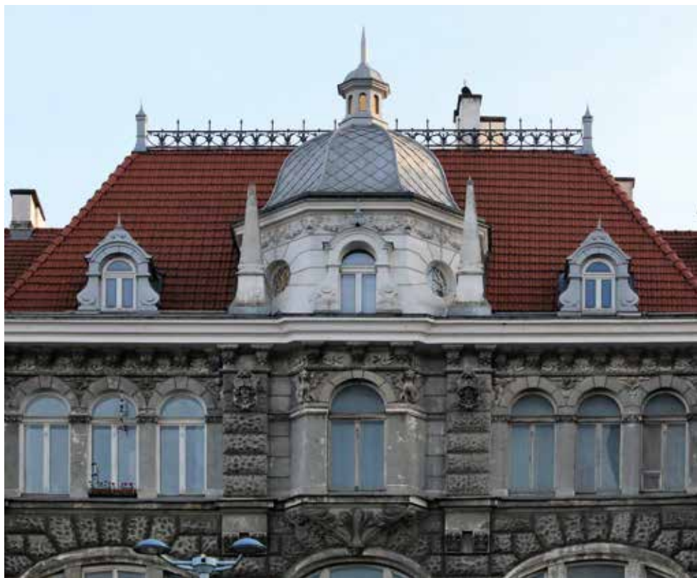
Wysoki, ceramiczny dach oraz kopułka na osi elewacji frontowej kamienicy Hoserów, Al. Jerozolimskie 51 (1904-1905). Fot. J.S. Majewski
