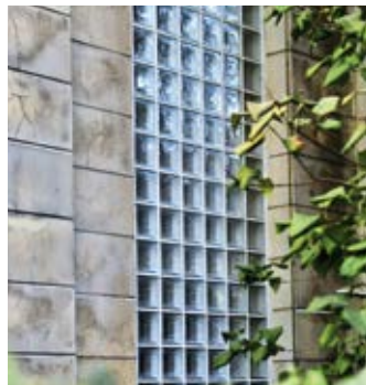
Blok FKW przy ul. Rudawskiej 4. Widać okno termometrowe wypełnione luksferami. Fot. J. S. Majewski
