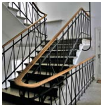
Balustrada schodów na klatce schodowej budynku przy ul. Wawelskiej 76. Fot. M. Majewski
