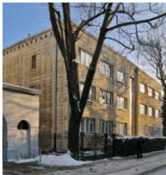
Blok FKW przy ul. Rudawskiej 4. Widać okno termometrowe wypełnione luksferami. Fot. J. S. Majewski
