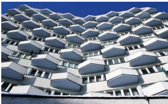
Układ balkonów na wachlarzowych elewacjach bloku przy ul. Grójeckiej 19/25 tworzy złudzenie optyczne. Fot. J. S. Majewski
