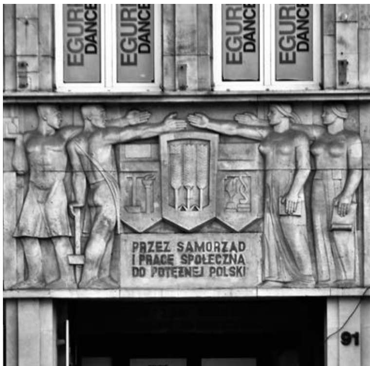
Płaskorzeźba na fasadzie gmachu Związku Zawodowego Pracowników Samorządu Terytorialnego w Al. Jerozolimskich 91. Fot. J. S. Majewski
