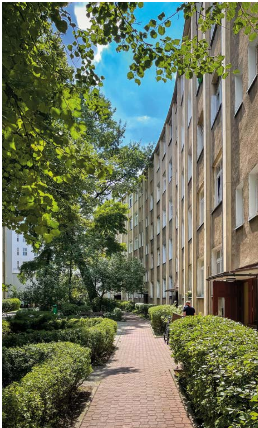
Drugi Zespół Mieszkaniowy Zakładu Ubezpieczeń Społecznych ul. Niemcewicza 7-9. Fot. M. Majewski
