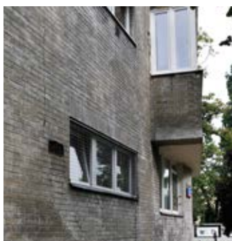
Narożnik kamienicy przy ul. Asnyka 2. Fot. J. S. Majewski
