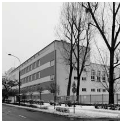
Gmach dawnej szkoły Wandy Szachtmajerowej przy ul. Białobrzeszkiej 44. Fot. J. S. Majewski
