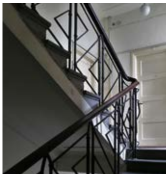
Balustrada w domu przy ul. Glogera 3. Fot. J. S. Majewski
