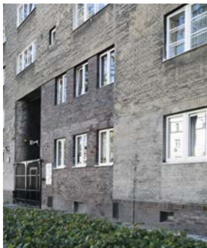
Blok mieszkalny FKW przy ul. Koszykowej 79a. Wysoki prześwit bramny licowany wokół wiśniowym klinkierem kontrastującym z elewacjami z szarej cegły cementowej. Fot. J. S. Majewski
