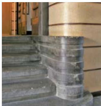
Detal obramienia schodków kamienicy przy ul. Grójeckiej 34. Fot. J. S. Majewski
