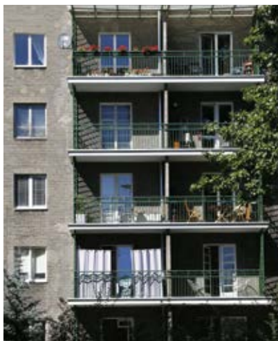
Blok mieszkalny FKW w al. Niepodległości 245. Tylne elewacje budynku z szarej cegły. Widok z wnętrza kwartału. Fot. J. S. Majewski
