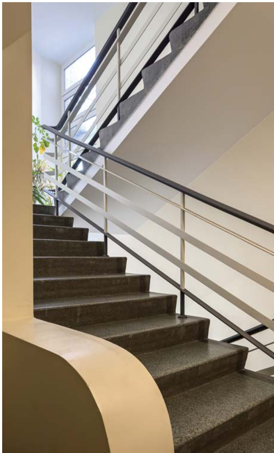
Klatka schodowa w budynku przy ul. Radomskiej 22. Fot. M. Majewski
