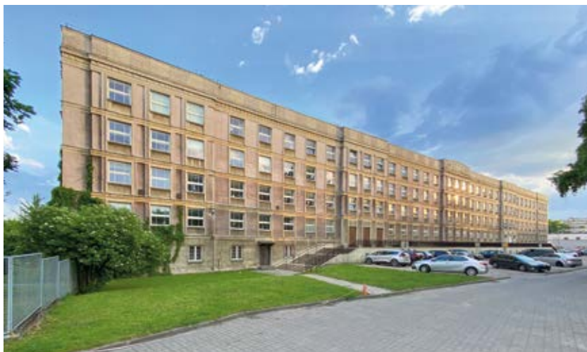
Gmach Wydziału Geologii UW przy al. Żwirki i Wigury 93/95. Fot. W. Kmieć
