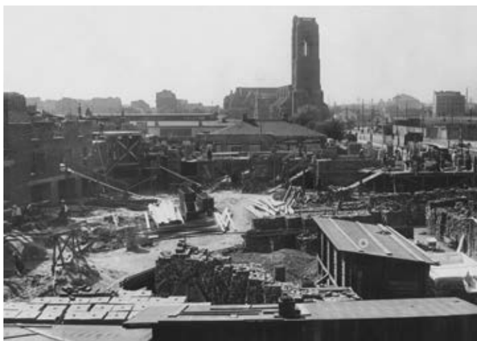
Budowa domów w okolicy ulicy Filtrowej. W tle widoczny kościół św. Jakuba, ok. 1927 r. NAC
