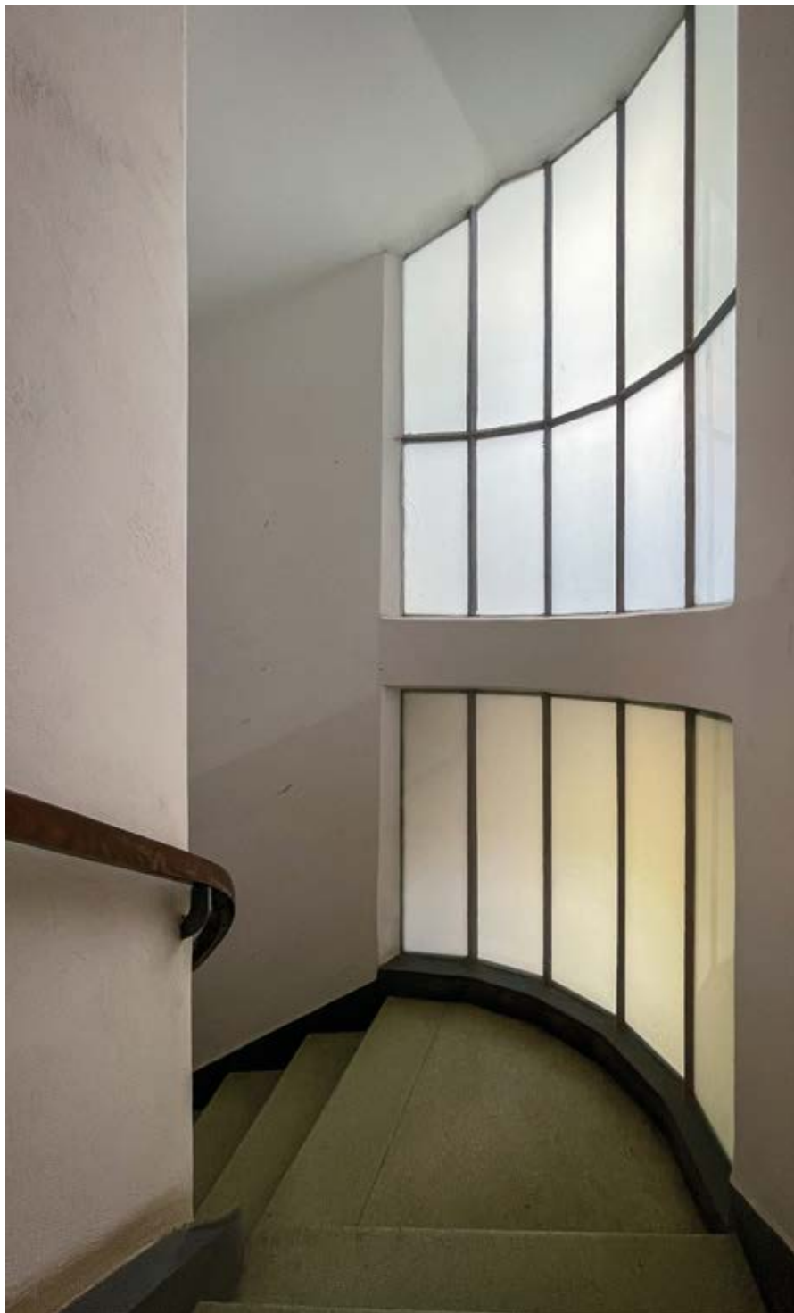
Klatka schodowa w budynku przy ul. Słupeckiej 2a. Fot. M. Majewski
