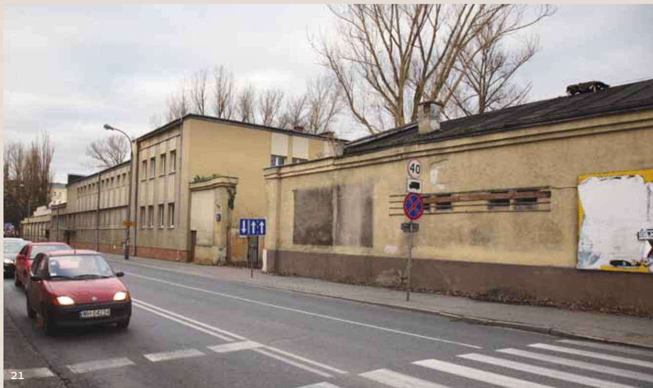
21. Budynek przy ul. Szwedzkiej 2 – w latach czterdziestych kwatery pododdziału operacyjnego NKWD
