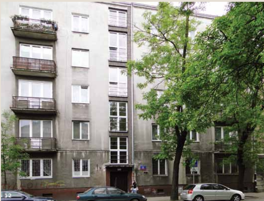
12. Budynek przy ul. Szerokiej 8, wykorzystywany przez WUBP w Warszawie
