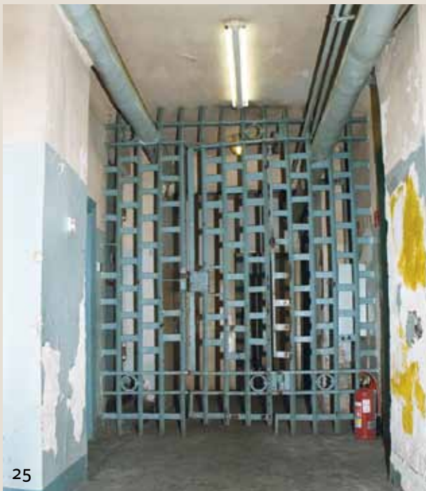
24.25. Budynek należący do Cerkwi Prawosławnej przy ul. Cyryla i Metodego 4 – w latach czterdziestych siedziba stołecznego Urzędu Bezpieczeństwa (24); drzwi do celi w piwnicy (25)
